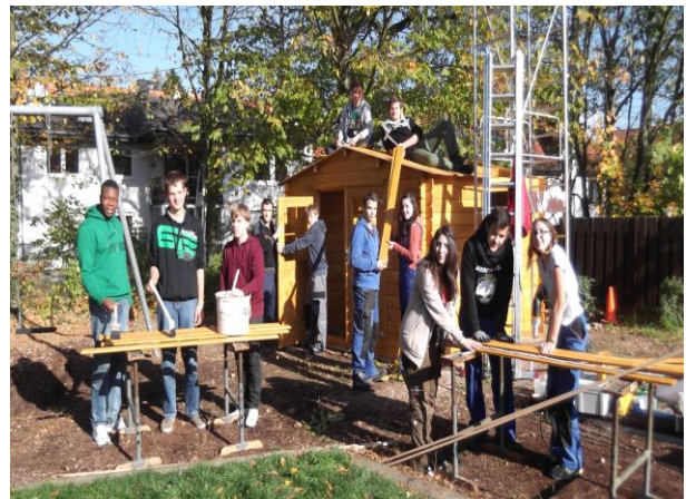
Bau eines Gerätehauses an der Don-Bosco-Schule
